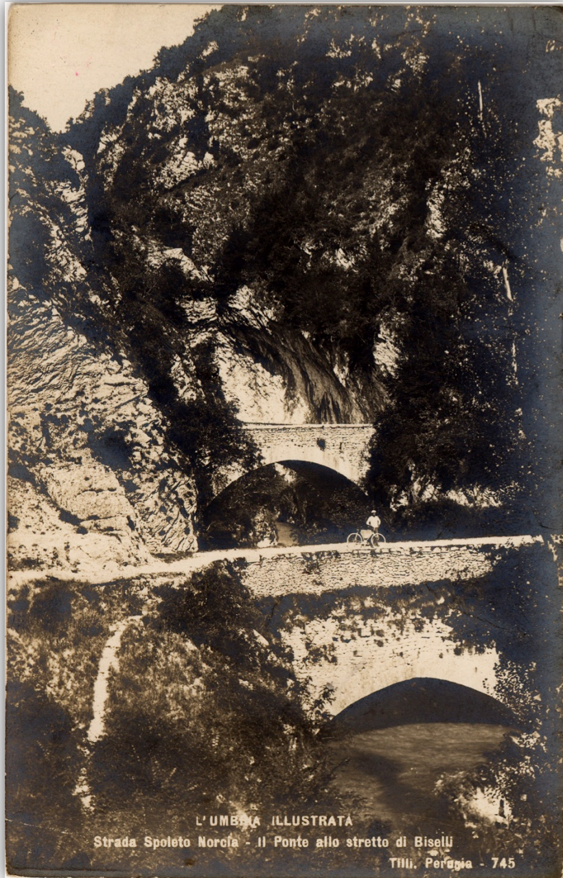
"Strada Spoleto Norcia – Il Ponte allo stretto di Biselli" Cartolina, inizi '900. Tilli L'Umbria Illustrata
